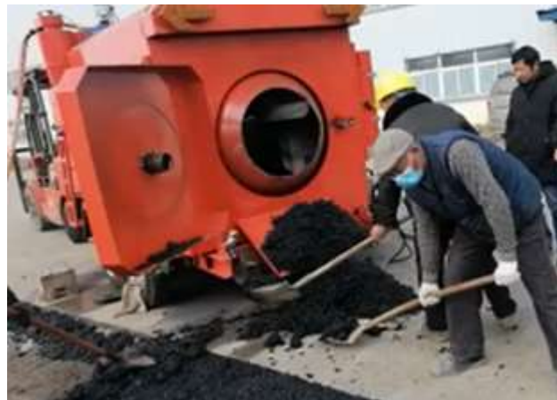
Equipo portátil de Calentamiento de la MAA para bacheo.
